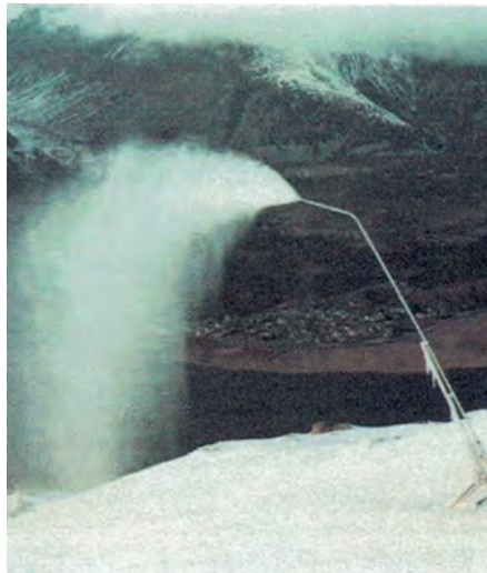
Die HKD Schneilanze Mitte der 80er Jahre verbrauchte rund 2.900 Liter Druckluft pro Minute.
