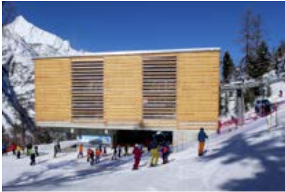
Der Holzaufbau der Talstation im Ort Tuftern wurde von der Brawand Zimmerei AG aus Grindelwald realisiert.
