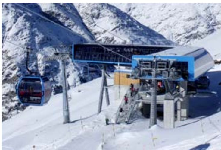
Die neue D-Line-Gondelbahn werdet das Skigebiet am Unterrothorn oberhalb von Zermatt massiv auf.
